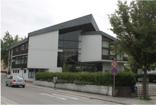
Abbildung 14: Albert-Schweitzer-Straße 2 (Quelle: WHS, 2018)
