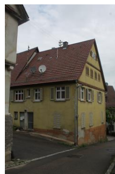
Abbildung 11: Grabengasse 7 (Quelle: WHS, 2018)
