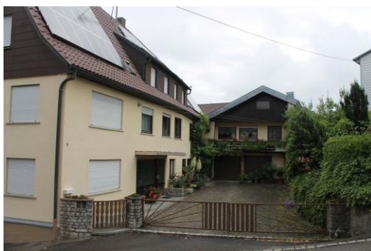
Abbildung 7: Photovoltaikanlage in der Grabengasse 4 (Quelle: WHS, 2018)
