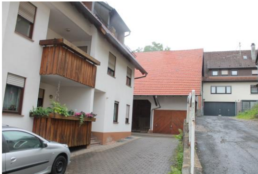
Abbildung 35: Große Gasse 6 (Scheune) (Quelle: WHS, 2018)
