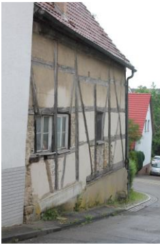
Abbildung 37: Kleine Gasse 1 (Scheune) (Quelle: WHS, 2018)
