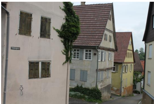
Abbildung 51: Grabengasse 1, 3, 5: Unternutzung, ggf. tlw. Leerstand (Quelle: WHS, 2018)
