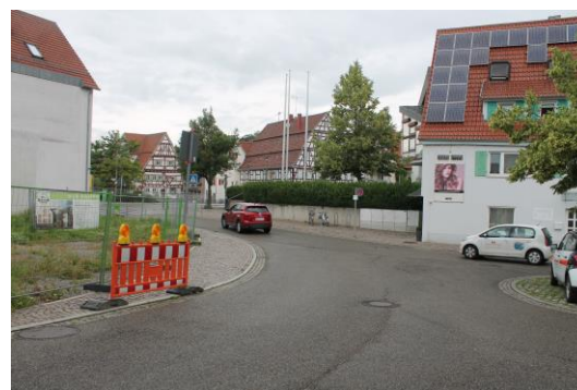
Abbildung 8: Photovoltaikanlage im Kreuzungsbereich Große Gasse / Wiesentalstraße (Quelle: WHS, 2018)
