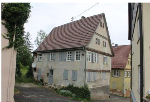
Abbildung 10: Grabengasse 3 (Quelle: WHS, 2018)
