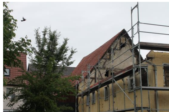
Abbildung 52: Große Gasse 1 (Scheune): Leerstand (Quelle: WHS, 2018)
